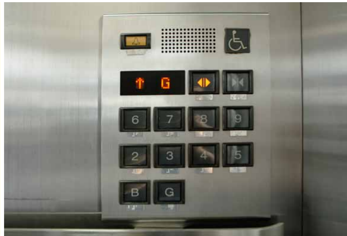
❖ 7. ลิฟต์ผู้โดยสาร (ทุกแห่ง) ติดอักษรเบรลล์สำหรับผู้พิการทางการมองเห็น
