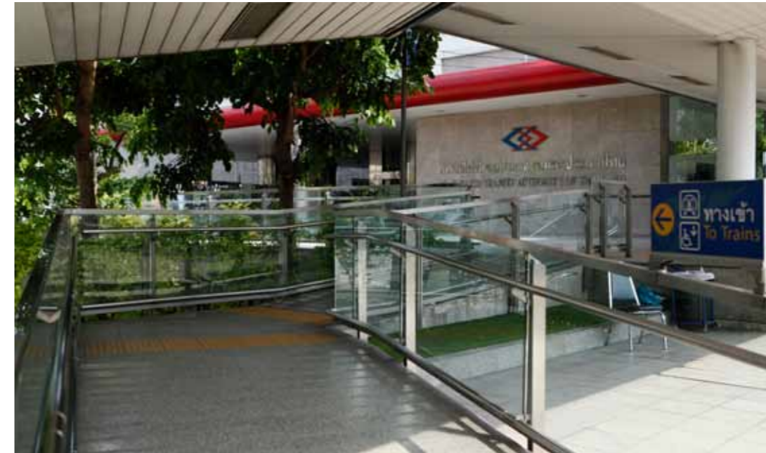
❖ 1. ทางลาดทางเข้าด้านหน้าอาคารจอดรถด้านถนนลาดพร้าว
