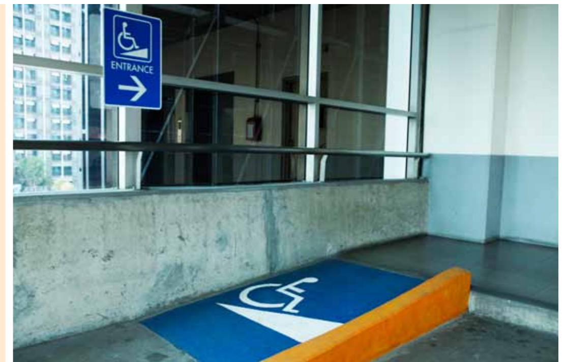
❖ 2. ขอบทางลาด จำนวน 7 จุด ขนาดกว้าง 10 ซม. สูง 15 ซม. ยาวตลอดแนวทางลาดตำแหน่งหน้าลิฟต์ 1-2 ชั้น 2 ถึงชั้น 8
